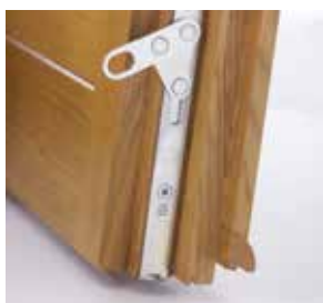
Tenue du semi-fixe avec houssette en fenêtre et verrou en porte-fenêtre Meilleur maintien du vantail.
